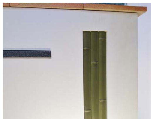
壁貼りパネル施工
