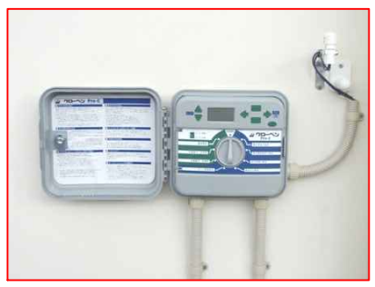
コントローラー・レインセンサー AC100V 設定時間/1分~6時間 設定回数/1~12回まで
