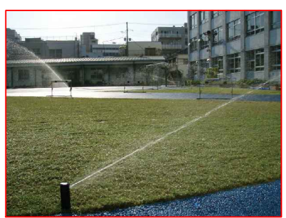
I-20ギアドライブヘッド ノズル番号: 1.5 水圧: 300kpa 半径: 約7.4m 水量: 5.9L/min
