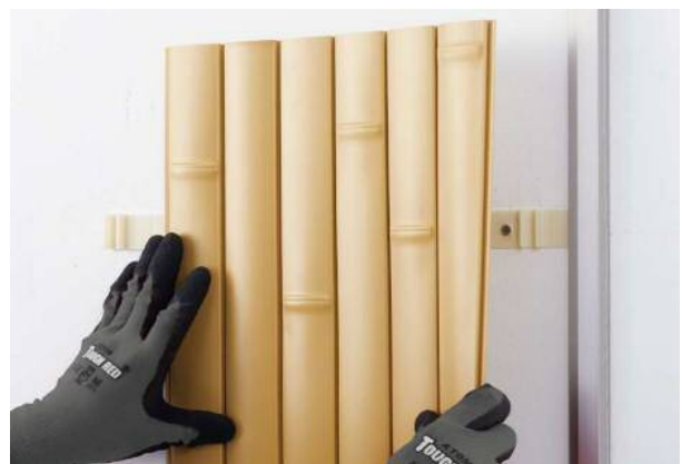
固定プレート取り付け方法
